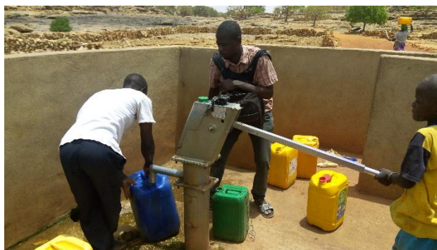
Eau potable: aménagement des pompes dans le village
